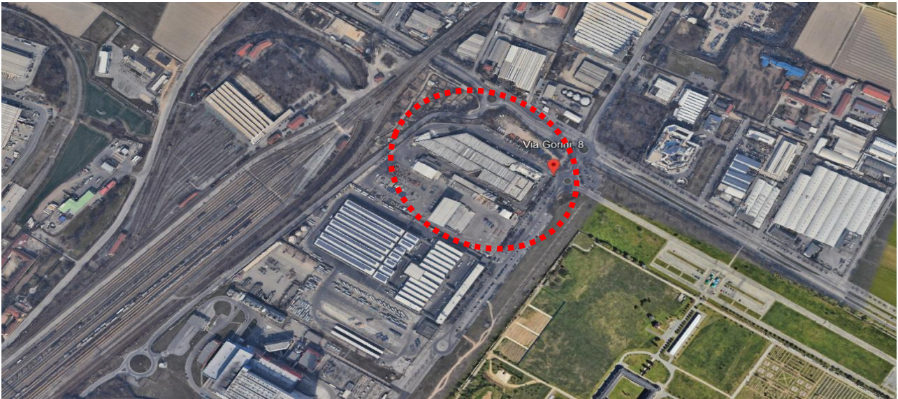
Figura 3 - Vista dall'alto del sito AMIAT di Via Gorini, 8 a Torino
